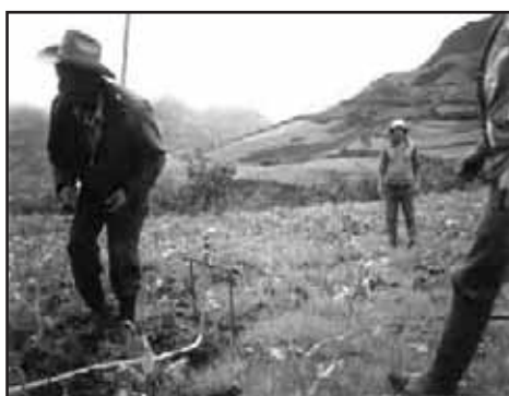
Figura 26 Prueba del sistema de riego en Dalincochas
